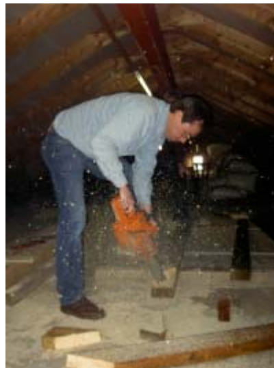
Ohne Fachmann läuft nichts: Georg Verwayen beim Zurechtsägen der Deckenkonstruktion auf dem Dachboden des Sporthauses
